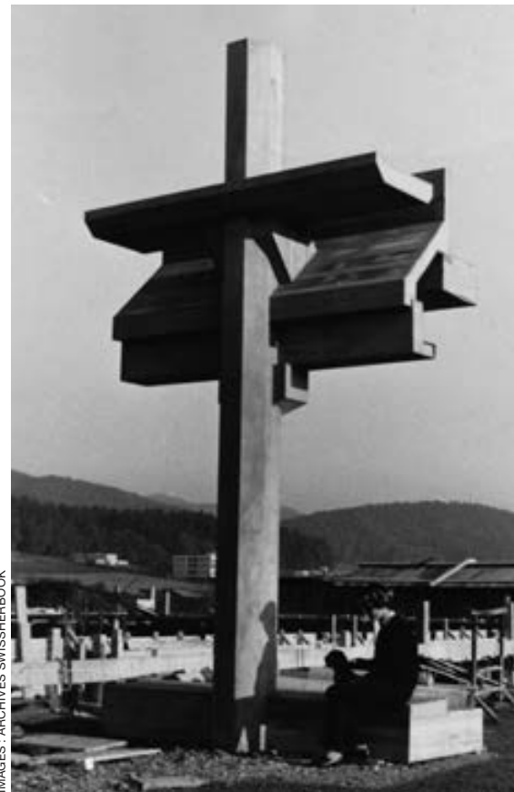
24 colonnes octogonales équilatérales en béton sur la façade portent trois étages au-dessus du sous-sol ainsi que le toit.
